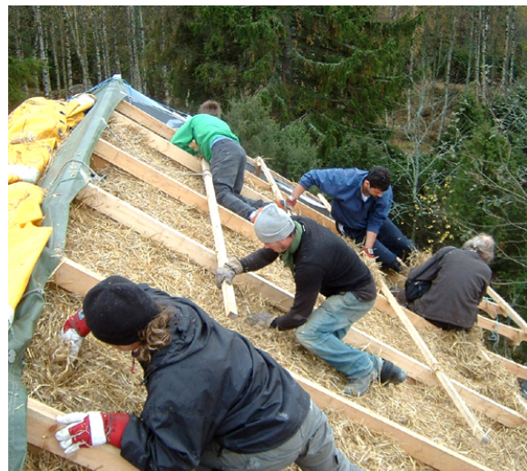
Hier wird das Dach mit Stroh gefüllt.
